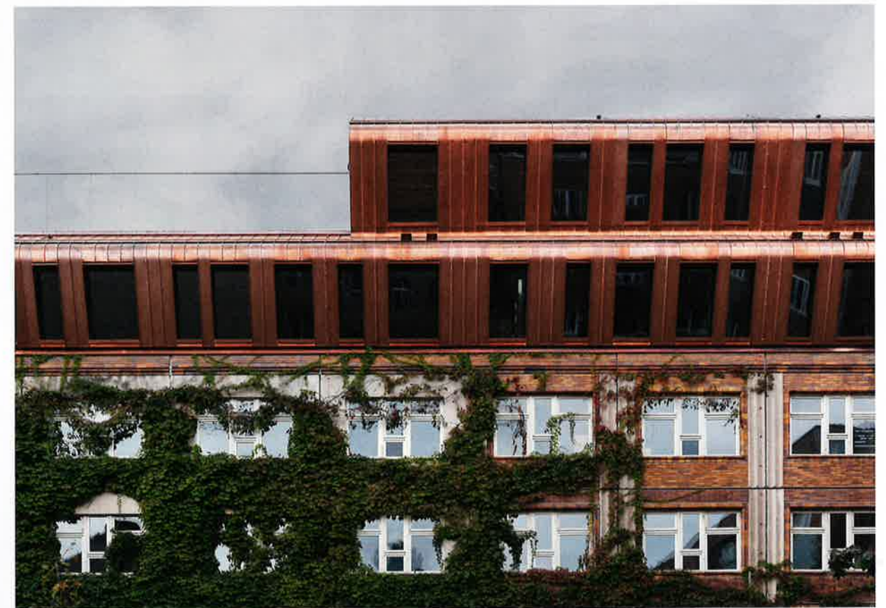
Ein weich geschwungener Holzaufbau mit Kupferverkleidung krönt nun den bestehenden Plattenbau, ein Schulkomplex aus Elementen der „Schulbaureihe 80“ (SBR 80).
